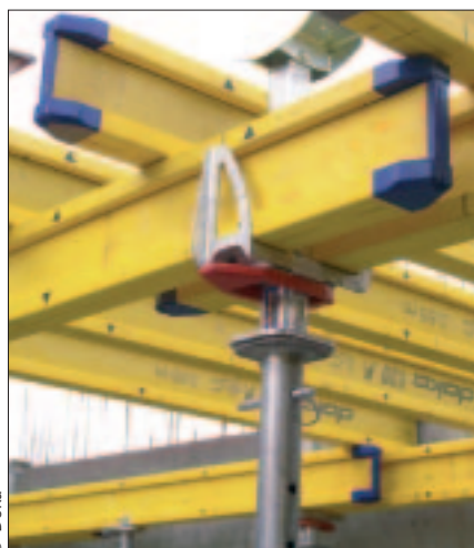
Hochleistungen mit Holz: Die Verstärkung des Träger-Endes mit Kunststoff verlängert die Lebensdauer um den Faktor 3.
